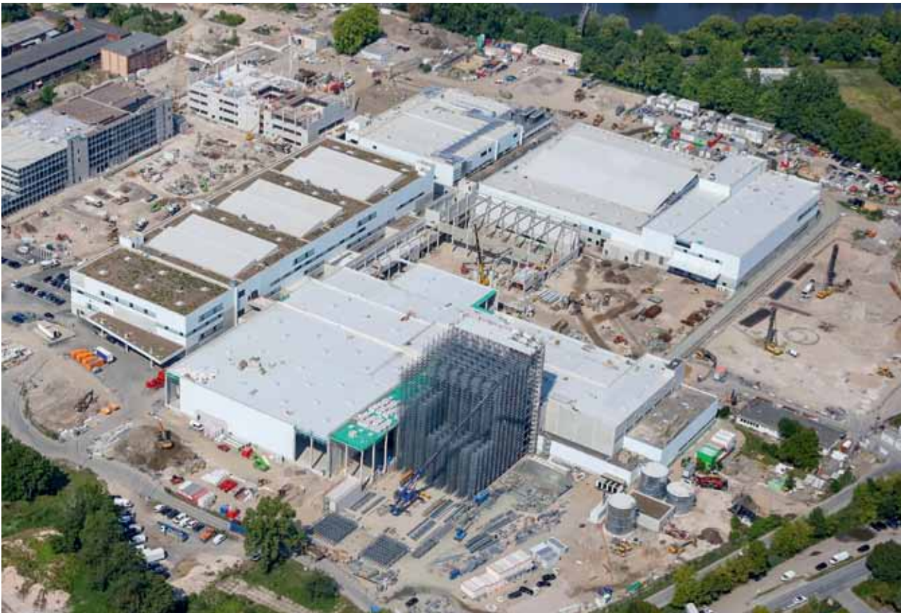
Blick auf die Baustelle des Innovations-Campus auf dem ehemaligen Allessa-Gelände
